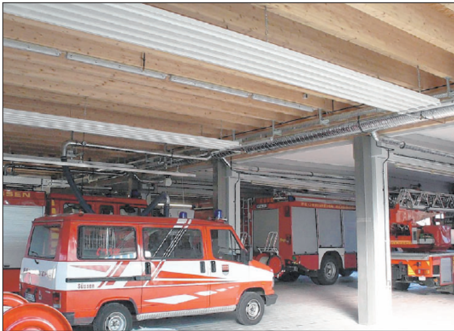
Genügend Platz für ihre Fahrzeuge hat jetzt die Süßener Feuerwehr. Die Erweiterung und Modernisierung des Feuerwehrmagazins soll bei Alarm einen reibungslosen Ablauf ermöglichen. Foto: privat
