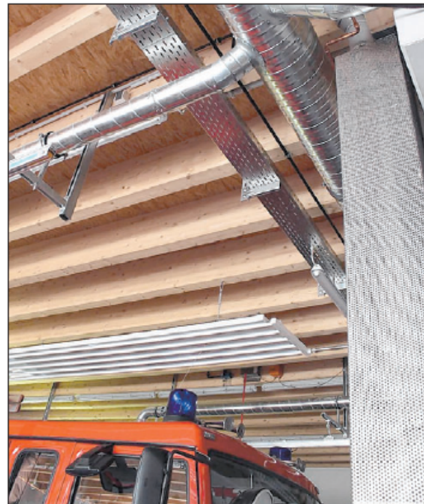
18 Monate Bauzeit liegt hinter den Feuerwehrleuten und sie haben kräftig mit angepackt. Das Ergebnis kann sich sehen lassen. Fotos: Staufenpress
